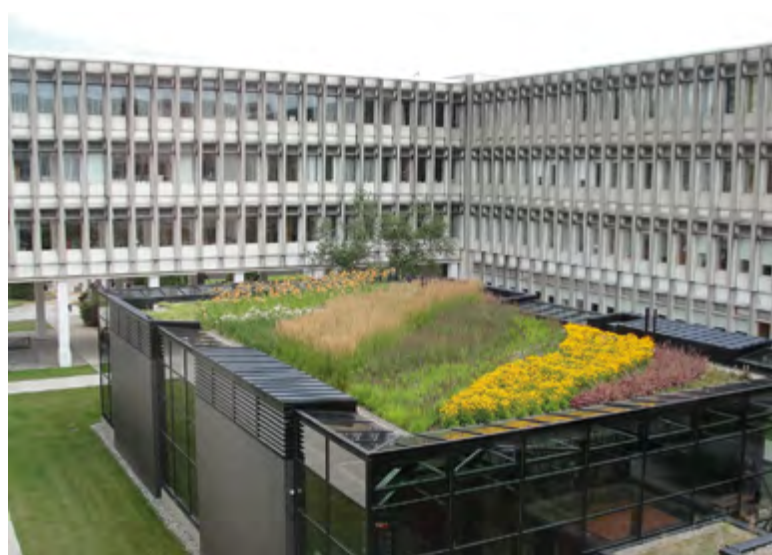
Fig. 30 - Esempio di tetto verde Foto di René Bélanger
